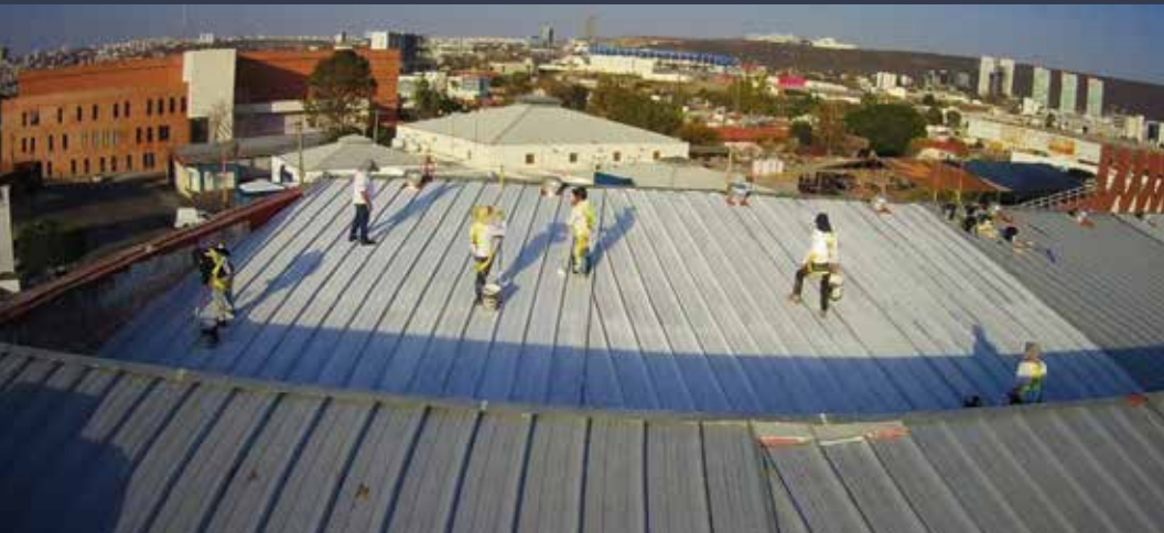
Aplicación de Impershield Merida 4700 m2
